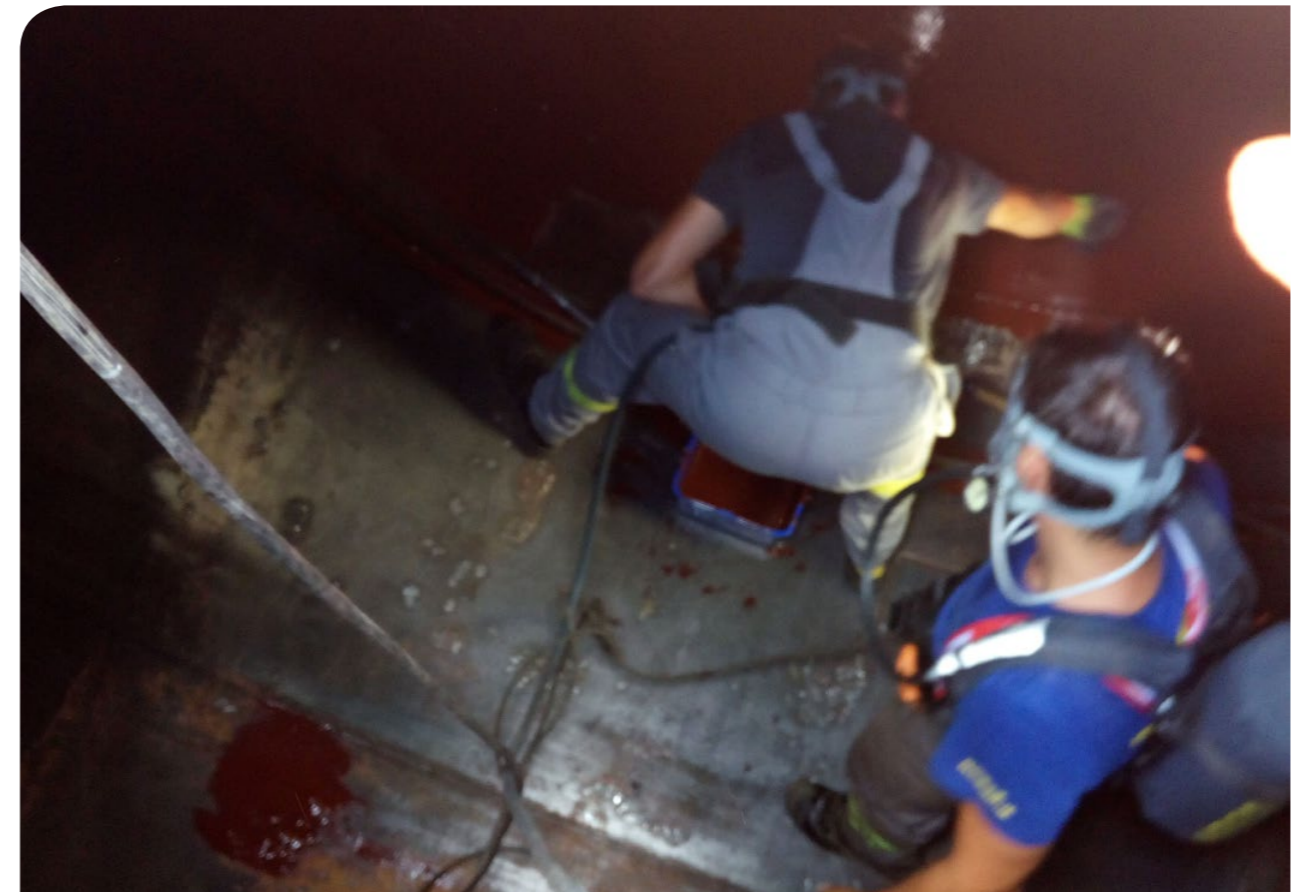
▼ SNS Dambořice - nátěr skladovací nádrže.
