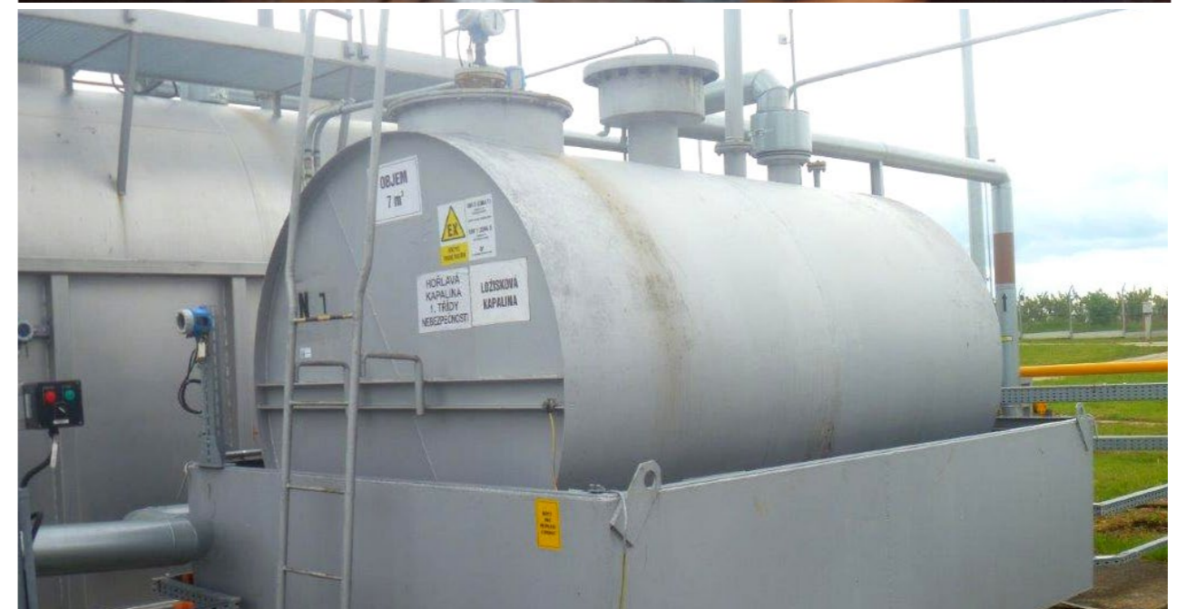
▲ Revize a kontrola skladovacích nádrží -Bílovice B.
